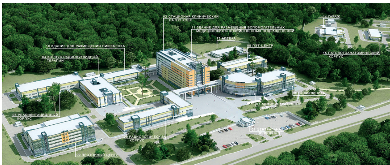
Общий вид ФВЦМР ФМБА России после окончания строительства
